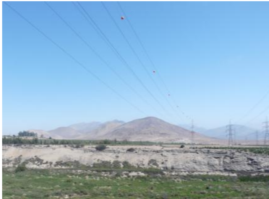
Figura 6. Balizas de señalización aeronáutica dispuestas en la línea de transmisión.
